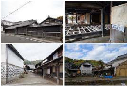
旧鈴木家住宅 保存修理現場
